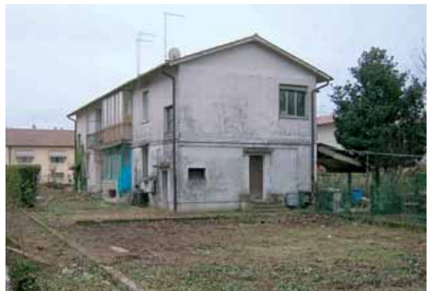
Il fabbricato da ristrutturare a Maserada.
