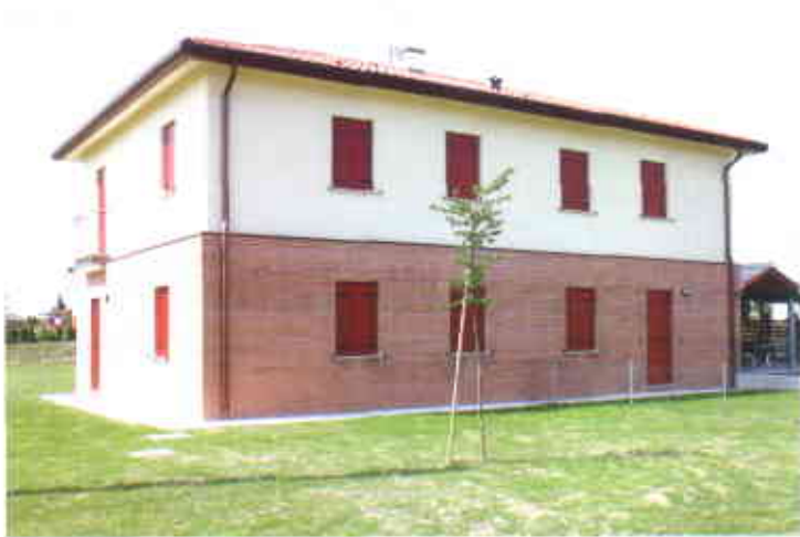
In copertina: Nervesa della Battaglia - Via Priula, 12 alloggi.
